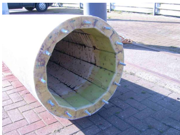
Abbildung 4: Fuß des armierten Holzastes mit 12 herausstehenden Gewindestangen vor der Verankerung im Fundament
